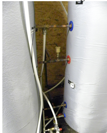
Les cumulus chauffage en cours d'installation
