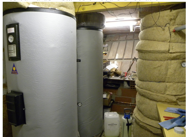
Les cumulus installés en cours d'isolation
